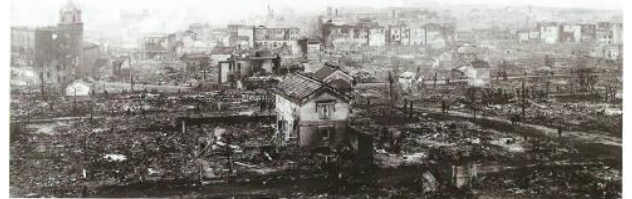
函館大火の焼け跡
